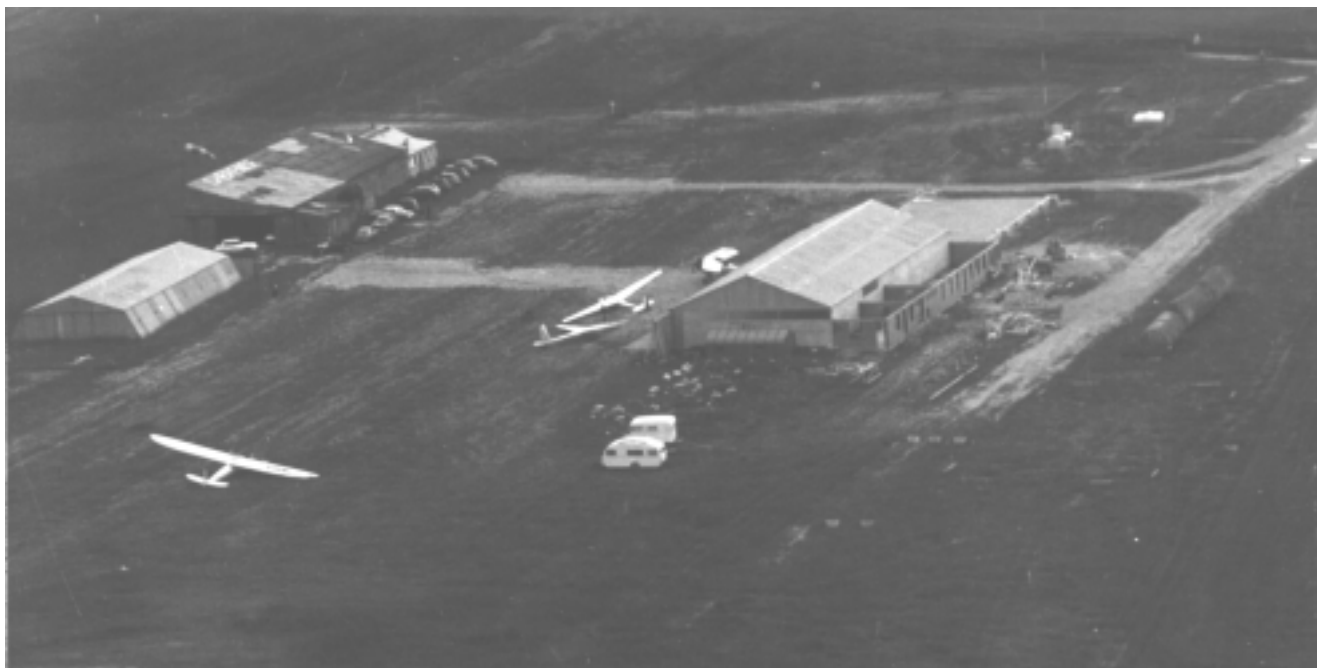
La construction des nouveaux hangars.
